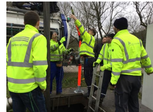
Erneuerung Ausrüstung „ÜPW Bad Berka“
