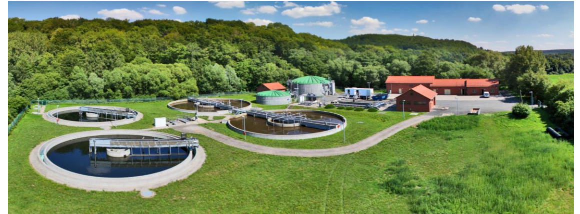
Kläranlage Bad Berka
