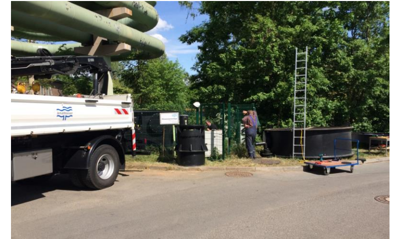
Instandsetzung Biofilter „Burgauer Weg“
